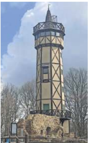
Już w najbliższą sobotę będzie można wejść na wieżę widokową na Gromniku
