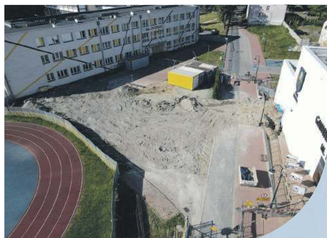
Na budowie nie widać pracowników, ani maszyn
