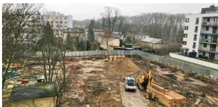
Ponownie ruszyły prace przy budowie Centrum Administracyjnego w Ciechanowie
