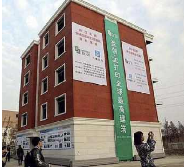
5. Wielopiętrowy dom firmy Winsun wykonany techniką druku 3D
