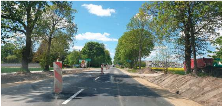
Inwestycje w mieście i powiecie na razie przebiegają bez zakłóceń. Tak jest również w prowadzonej przez powiat przebudowie drogi Kalinówka – Lublin, gdzie główne prace drogowe już zostały wykonane i wszystko wskazuje na to, że całą inwestycję uda się skończyć przed terminem
