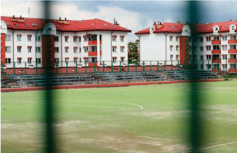
Decyzją sanepidu boisko przy SP nr 30 z powodu spekań zostało wyłączone z użytkowania
