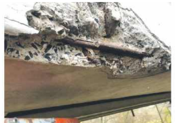
62. Ubytki, wykruszenie otuliny betonowej dźwigara głównego, korozja powierzchniowa odkrytego zbrojenia oraz kanału iniekcynowego.
