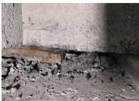
Stan łozysk stalowych
