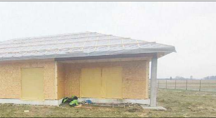
ry nie ma dachu. Jest tylko membrana
