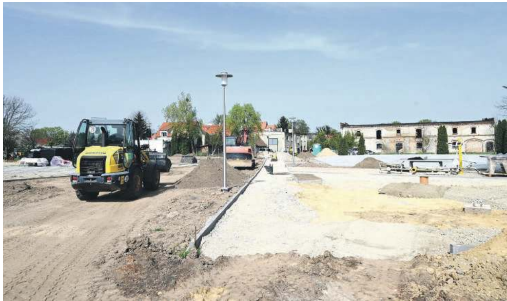
Trwa budowa skate parku w Strzeszowie
