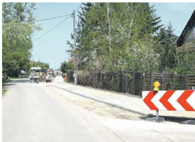
Budowa chodnika na ul. Stawowej w Rogożu dobiega końca
