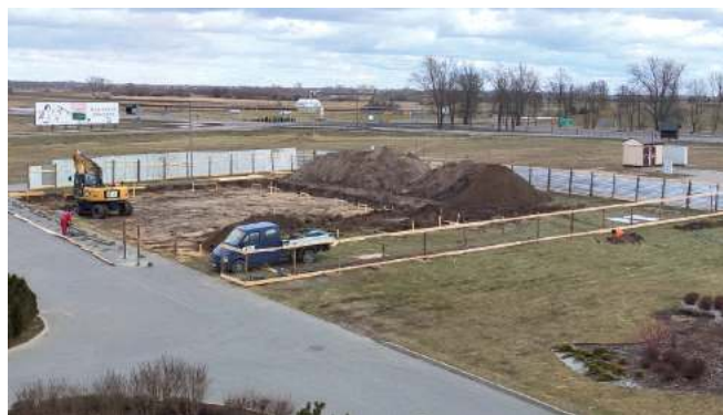
Ruszyła budowa przychodni w Kobylanach. Znajdą tam miejsce następujące gabinety: ginekologiczny, stomatologiczny, szczepień, zabiegowy, a także punkt apteczny
