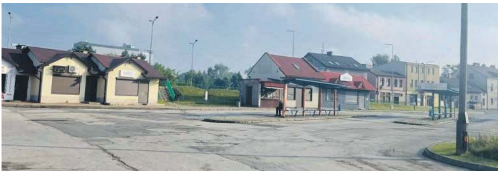
Zakończenie budowy centrum przesiadkowego w Trzebinii ma nastąpić w połowie listopada przyszłego roku
