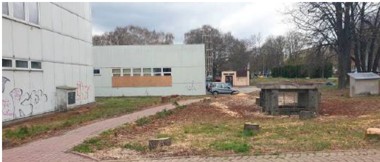
Niebawem znaczna część budynku starego ratusza podzieli los rosnących przy nim do wiosny tego roku drzew – zniknie z powierzchni
