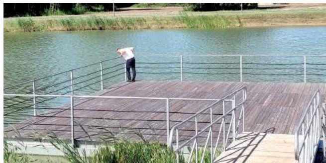
Odmulone zostały zbiorniki wodne, wybudowany został pomost, most i punkt widokowy
