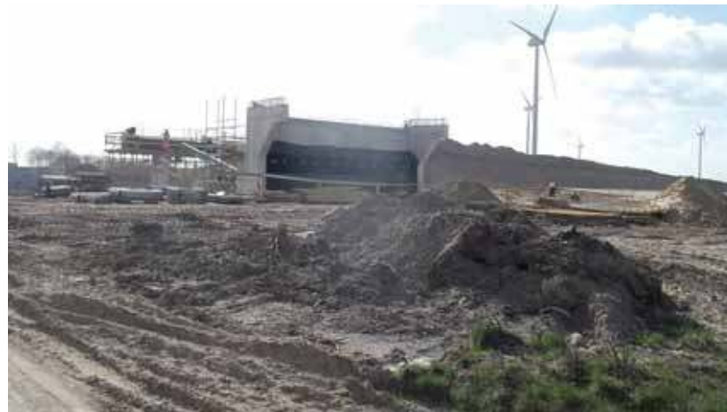
Budowa wiaduktu w okolicy Wiśniewa
