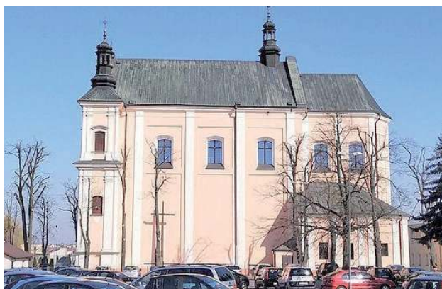
W środę, 21 lutego strażacy naprawili obłuzowany parapet przy oknie kościoła Podwyższenia Krzyża Św. w Łukowie, przy ul. Wyszyńskiego
