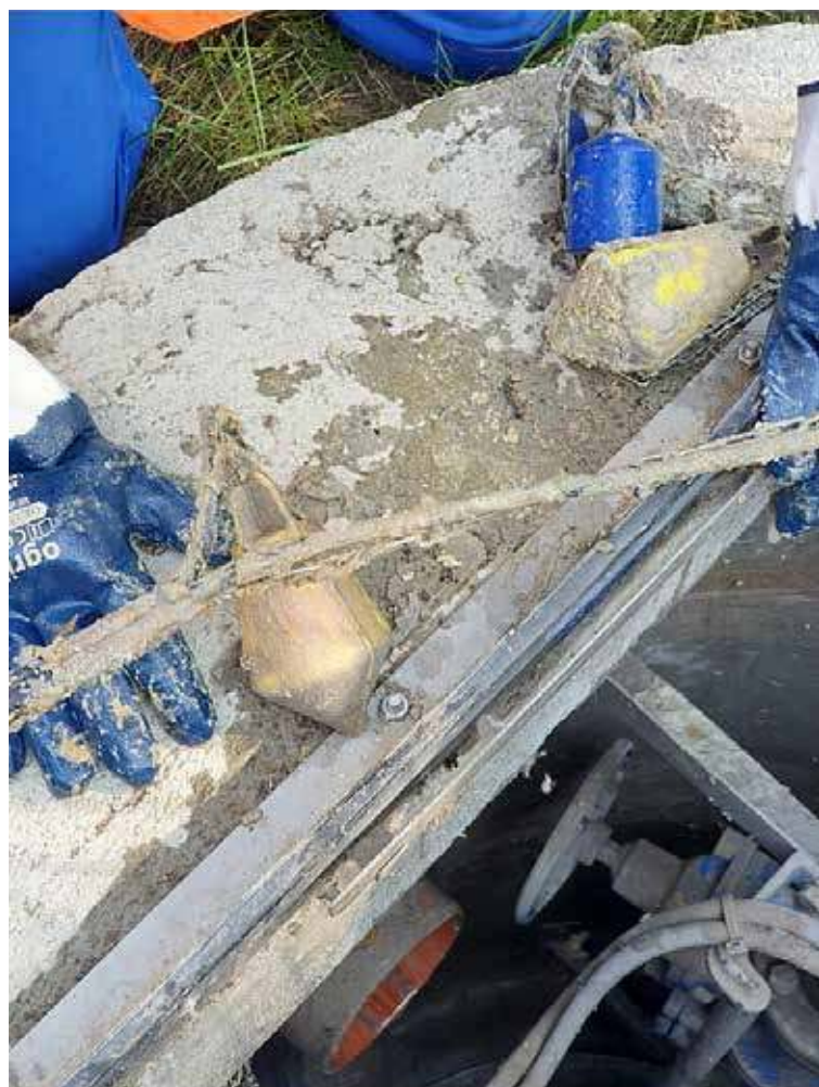
Zanieczyszczony czujnik pompy
