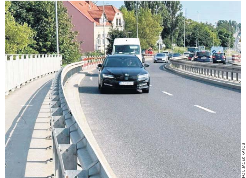
Wyremontowany wiadukt ma pięcioletnią gwarancję
