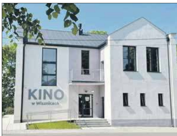
Jednym z zadań w ramach rewitalizacji była adaptacja budynku w centrum Wisznic na cele socjalne oraz komercyjne, wraz z zagospodarowaniem przyległego terenu
