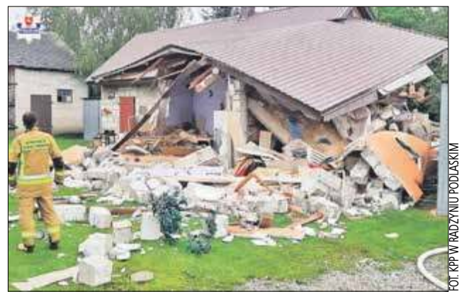
Eksplodowała butla gazowa, podłączona do kucharki
