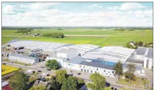
Zakład znajduje się na 5,5-hektarowej działce, na której pomieściłoby się prawie 8 pełnowymiarowych boisk piłkarskich
