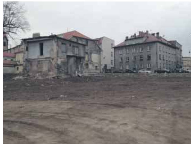
Pusty plac, a na nim częściowo zrujnowany budynek. Nie można go ruszyć, bo wewnątrz są transformatory i gdyby je uszkodzono, część miasta nie miałaby prądu
