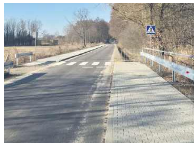
Droga gminna Grzmiąca - Górki po przebudowie.
