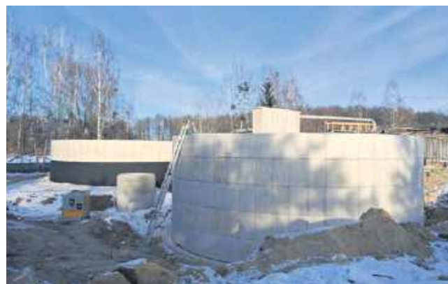
Trwają również zaawansowane prace przy modernizacji miejskiej oczyszczalni ścieków, które rozpoczęły się w lipcu 2025 roku.
