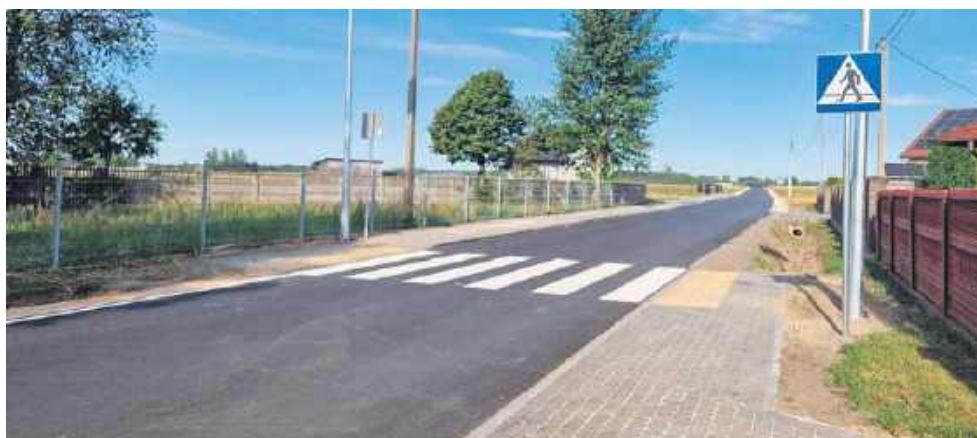
Przebudowana droga powiatowa relacji Białobrzegi-Bobrek na odcinku Brzeska Wola-Bobrek
