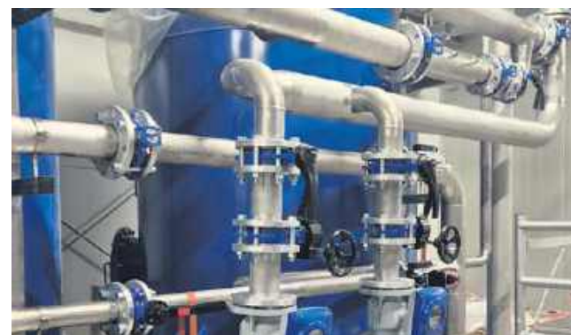
Stacja SUW w Wyśmierzycach (w budowie).
