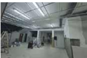
Początki remontu w Urzędzie Gminy w Wierzbicy
