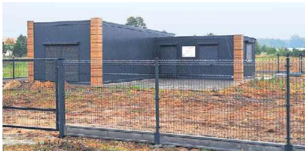
Świetlica wiejska w Ocieścu
