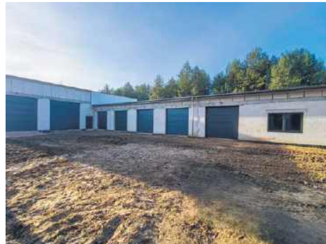
Rozbudowa Centrum Integracji Społecznej w Zbijowie Małym
