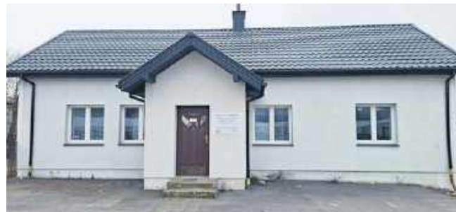
Modernizacja świetlicy w Zacharzowie
