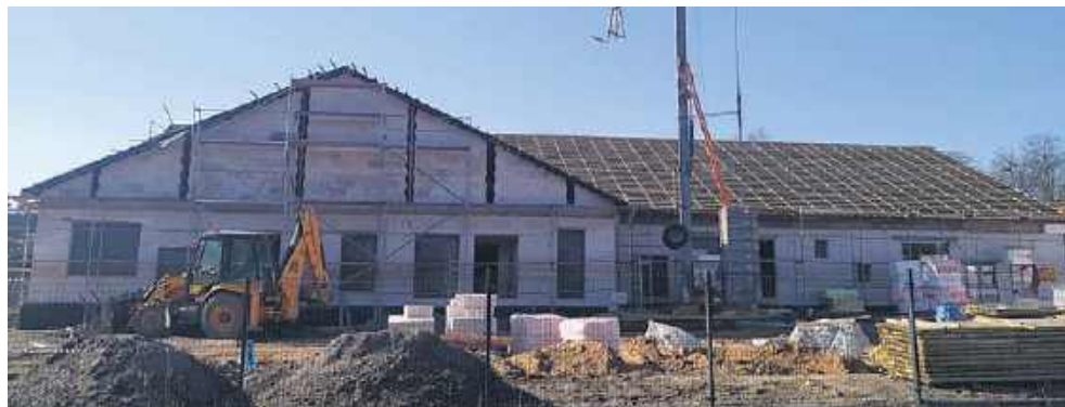
Budowa budynku na potrzeby żłobka i przedszkola
