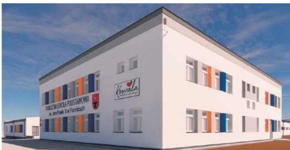
Projekt PSP w Parznicach po termomodernizacji
