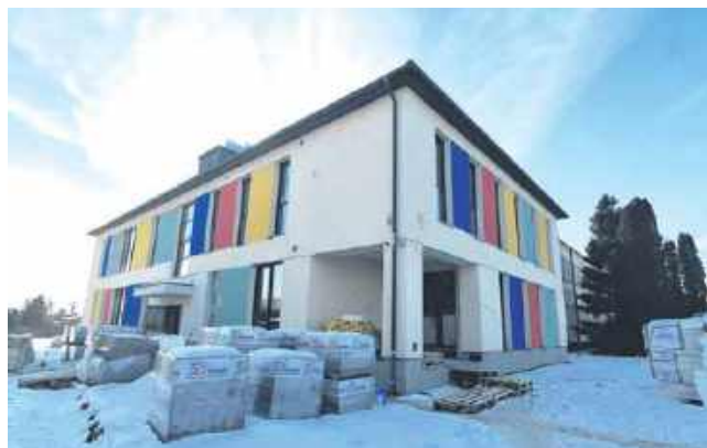
Obiekt żłobka w trakcie prac.
