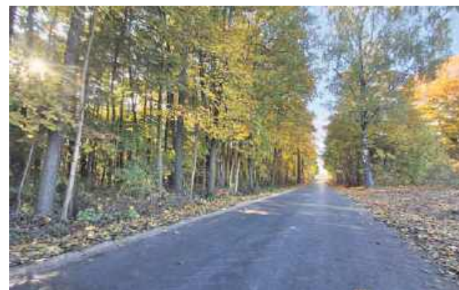
W październiku oddano do użytku przebudowany odcinek drogi gminnej w Sosnowicy.
