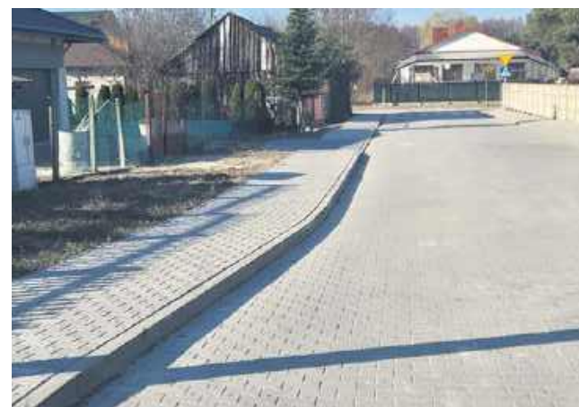
Ul. Sosnowa w Wyśmierzycach po przebudowie.
