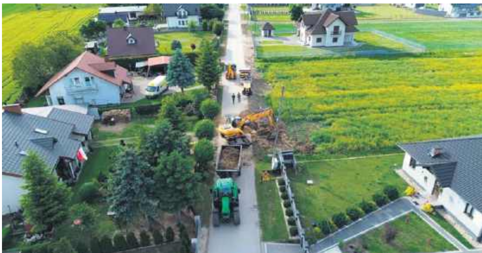
Budowa sieci kanalizacji ul. Górna
