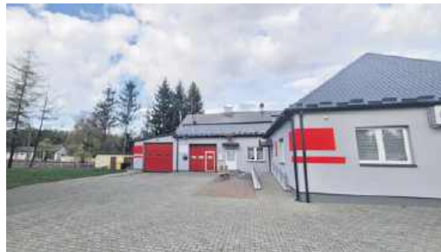
Modernizacja świetlicy w Pakosławiu
