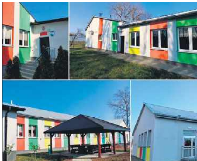
Rozbudowana Szkoła Podstawowa w Woli Goryńskiej zyskała nowoczesną świetlicę, bibliotekę i zaplecze edukacyjne.
