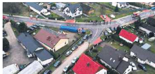
Droga powiatowa Wola Gałęcka – Gałki po remoncie
