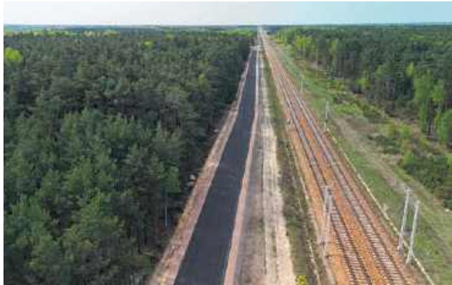
Droga powiatowa 1130W Stromiec – Wyborów
