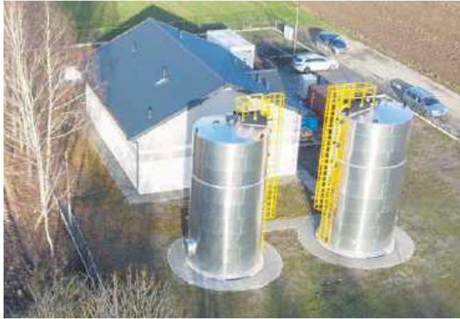
Stacja uzdatniania wody Jaszowice
