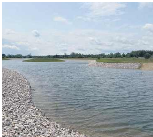
Wybudowany zbiornik retencyjny „Wysokin” w miejscowości Ceteń
