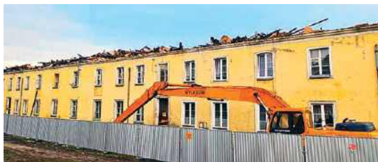
Budynek będzie rozebrany do poziomu fundamentów
