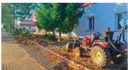
Prace przed budynkiem urzędu
