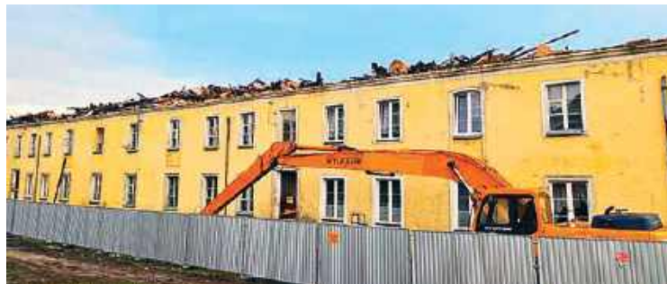
Budynek będzie rozebrany do poziomu fundamentów
