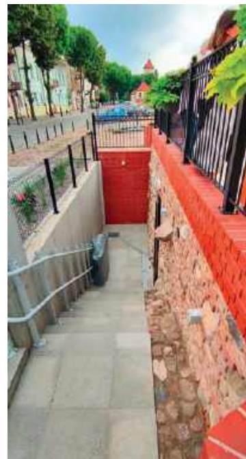
Wejście do zabytkowych piwnic zyska zadaszenie
