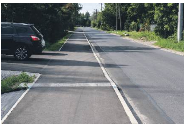
Tak wygląda wyremontowany fragment ul. Chrobrego
