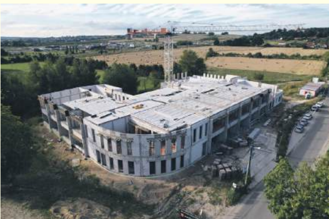
Obecnie trwa murowanie ścian piętra
