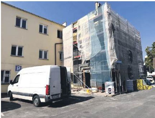
Trwa remont biurowca
