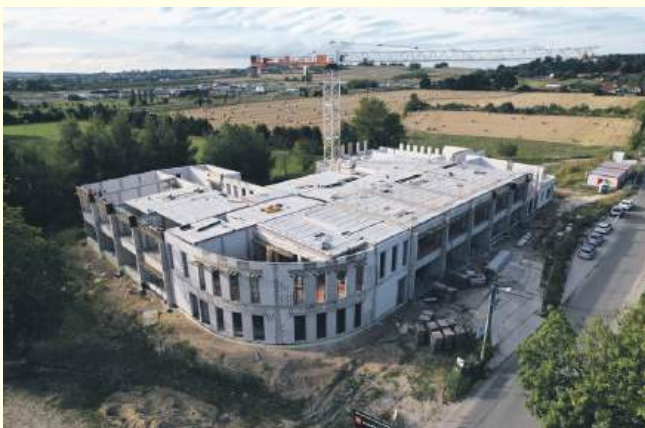
Obecnie trwa murowanie ścian piętra
