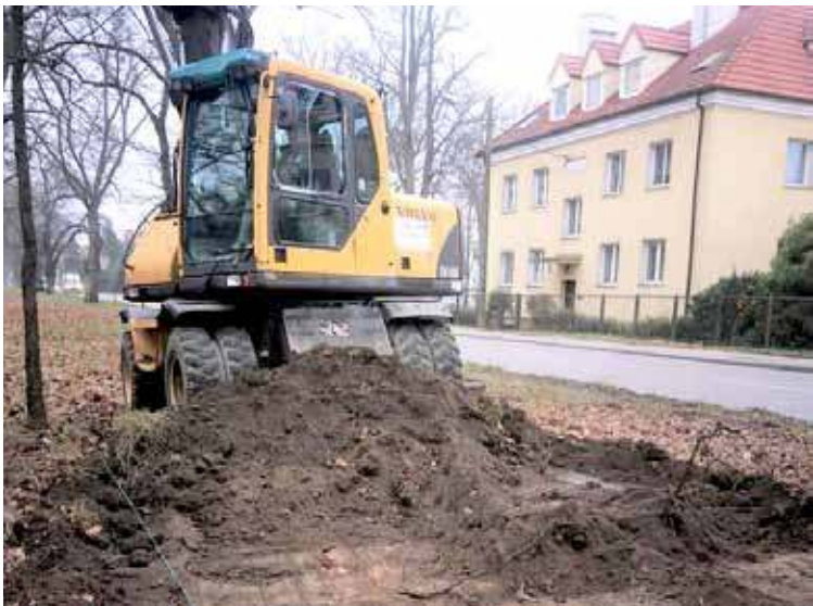
Ruszyły prace przy budowie ścieżki rowerowej na ulicy Spokojnej
