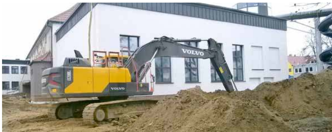
Zabytkowy obiekt odzyskuje dawny blask również z zewnątrz
