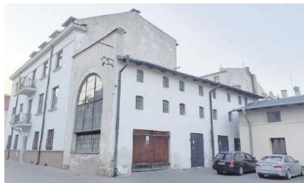
Radni dofinansowali remont elewacji kamienicy Czerskiego.
