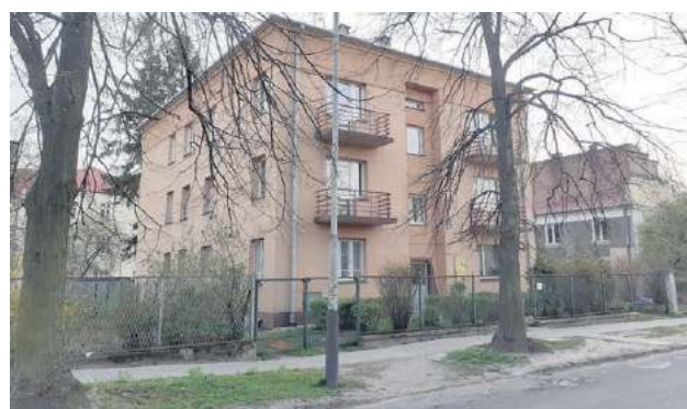
Miasto dofinansuje remont dachu na domu czynszowym przy ul. Kasprowiczu.
