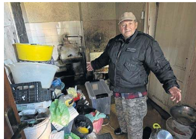
W budynku przy ul. Przy Torze 13 w Gdańsku panuje grzyb
