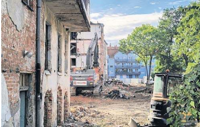
Trwa wyburzanie starych pustostanów. Ich miejsce zajmą bloki TBS
