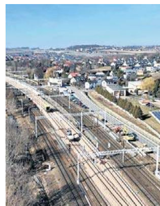
Modernizowana jest m.in. stacja Kraków Batowice
