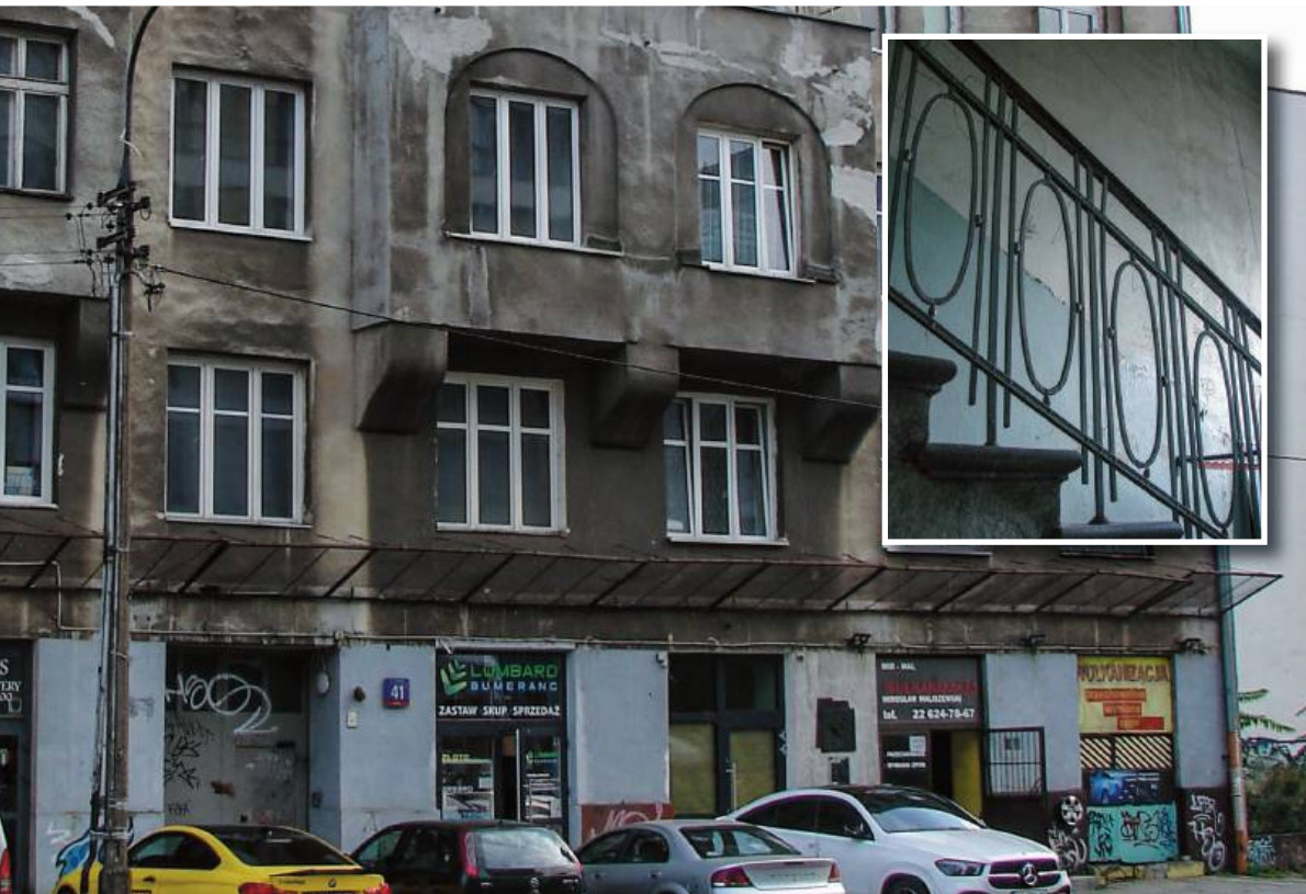
Kamienica przy ul. Chłodnej 41 i fragment balustrady schodów głównej klatki schodowej | fot. Janusz Sujecki/Gazeta Polska
