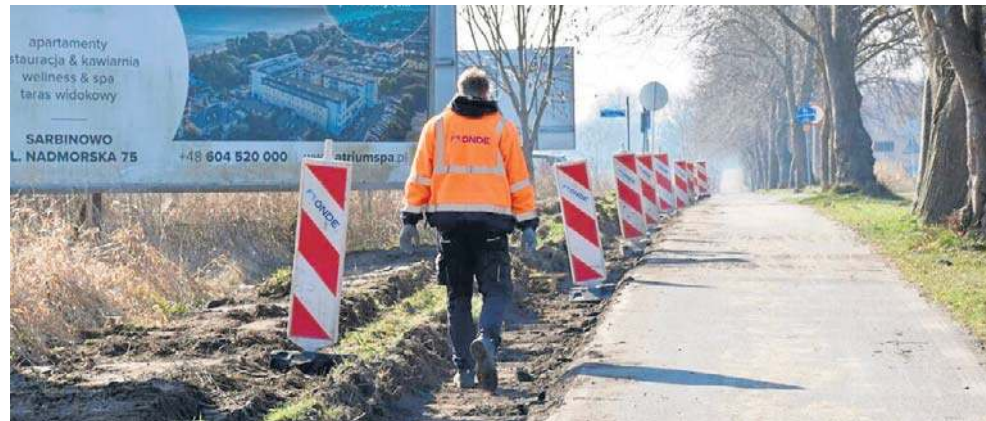
Rozpoczęła się przebudowa ścieżki rowerowej z Mścic do Mielna
