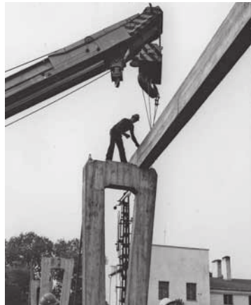
Budowa kładki nad torami
