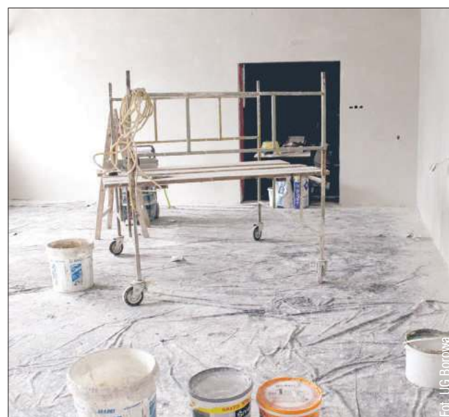
Po zakończeniu remontu sala świetlicowa będzie służyć jako miejsce spotkań dorosłych i dzieci.
