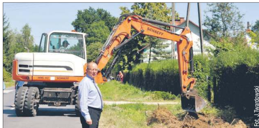
Wójt Stanisław Mieszkowski ogląda prace przy budowie chodnika w Górkach.
