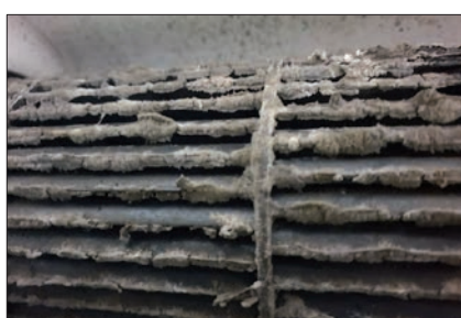
Fot. 3. Widok znacznego zanieczyszczenia i powstania osadu na turbinie wentylatora Źródło: własne autora
