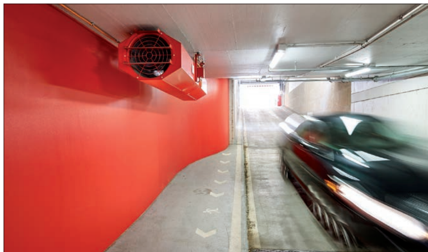
Rys. 2. System wentylacji strumieniowej
