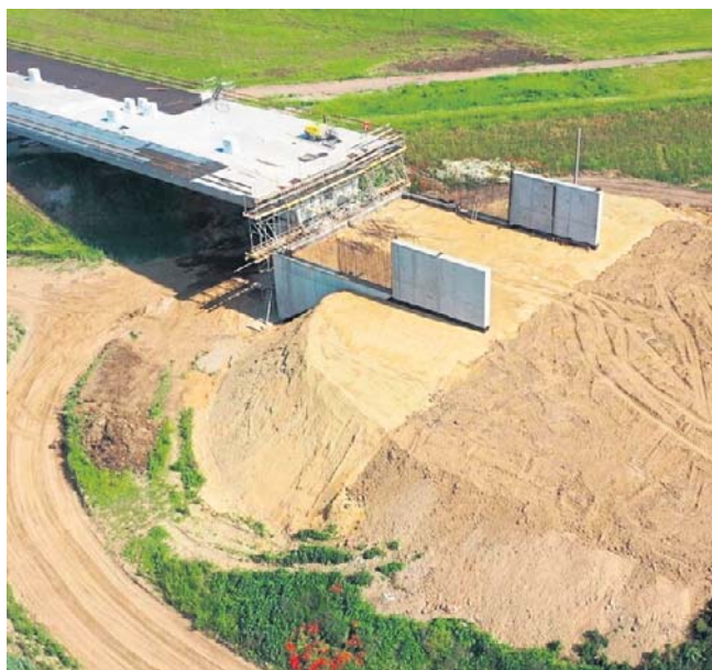
Gigantyczna przeprawa przebiega nad Odrą i zastąpi przeprawę promową pomiędzy Grzegorzowicami a Ciechowicami w ciągu drogi wojewódzkiej nr 421
