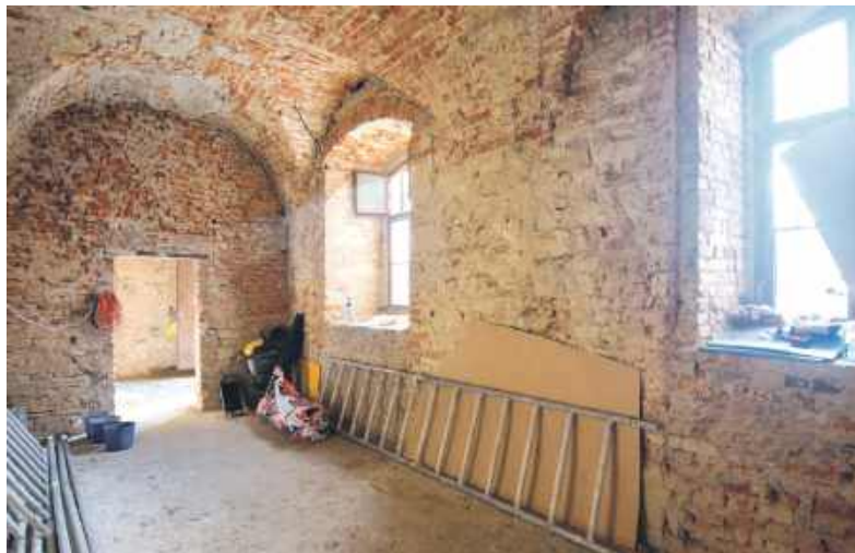
Ze ścian zakrystii skuto stare tynki
