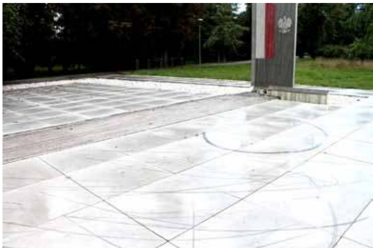
Widać wyraźnie, że granitowe płyty są pełne śladów po kołach rowerów
