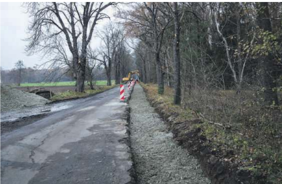
Przebudowa drogi na odcinku od skrzyżowania z drogą powiatową do wiaduktu przed miejscowością Łapczyce
