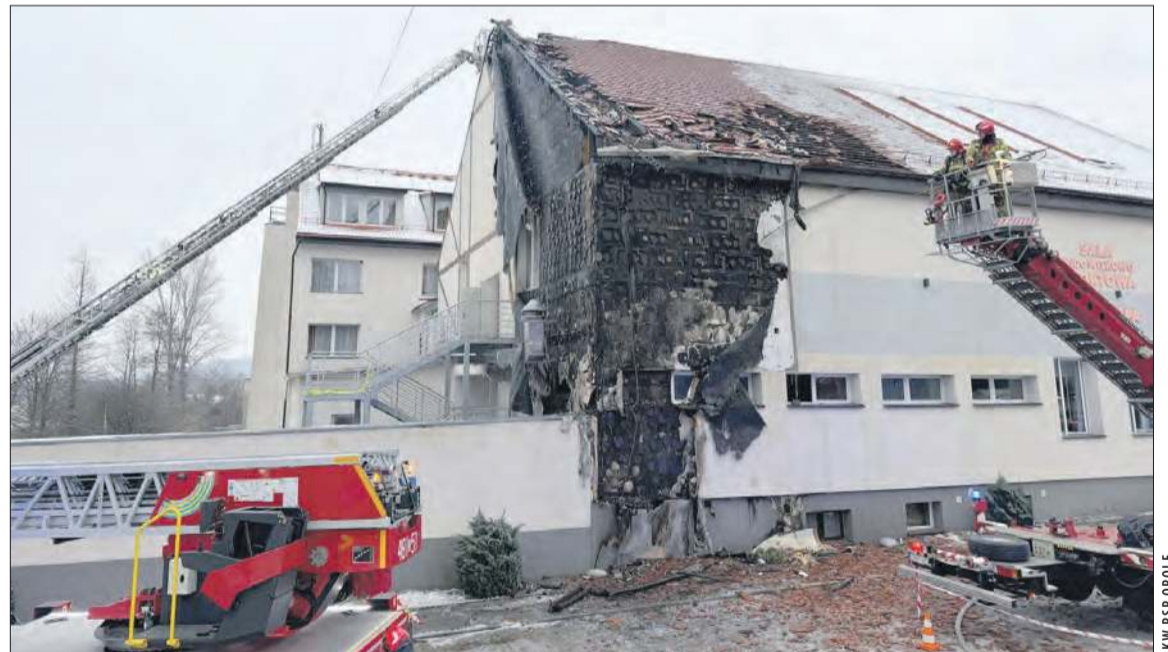
Pożar objął część budynku sportowego
