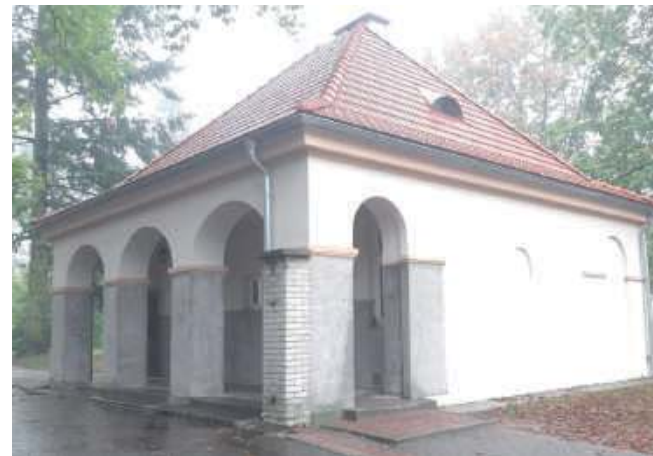
W tym miejscu uczniowie I LO będą mieli własne studio telewizyjne. Budynek „Prokopówki” został zrewitalizowany w ubiegłym roku
