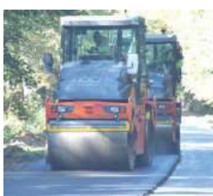
Z przebudowanej drogi o długości 4,9 km będą korzystać mieszkańcy gminy Baranów. Koniec prac ma nastąpić w sierpniu następnego roku
