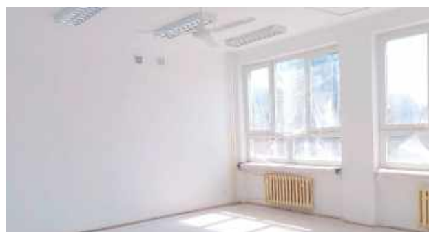
Jedna z sal oddziału przedszkolnego w Zespole Szkół w Karczmiskach podczas remontu. Pomieszczenie zyska nową wykładzinę, odświeżone ściany i sufity, oświetlenie oraz zmodernizowaną instalację elektryczną i sieć LAN
