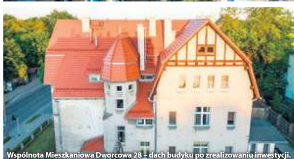
Wspólnota Mieszkaniowa Dworcowa 28 – dach budynku po zrealizowaniu inwestycji.
