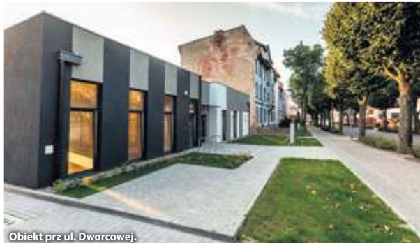
Obiekt przy ul. Dworcowej.
