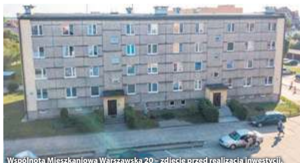
Wspólnota Mieszkaniowa Warszawska 20 – zdjęcie przed realizacją inwestycji.
