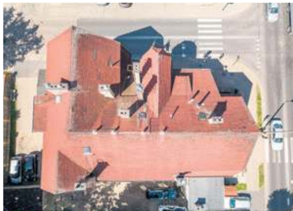
Wspólnota Mieszkaniowa Dworcowa 28 – dach budynku przed realizacją inwestycji.
