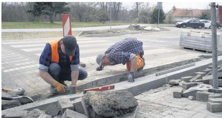
Mimo wyjątkowej sytuacji, trwają prace remontowe na ul. Brzegowej i ul. Konopnickiej w Strzelinie. Foto: UMIG Strzelin
