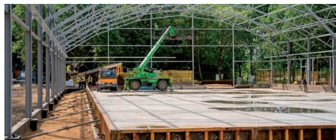
Zainstalowano już stalowe konstrukcje dachu
