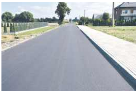
Przebudowana droga gminna w Fajstowicach
