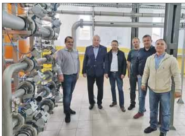
Unowocześniona została stacja uzdatniania wody w Kodniu. W ramach tej inwestycji wyremontowano studnie głębinowe
