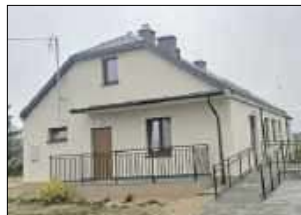
Budynek po dawnym przedszkolu został gruntownie wyremontowany
