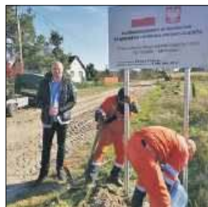
Na odcinku Romanów – Motwica o długości 2,4 km zostanie wybudowana nowa droga
