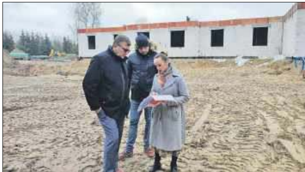
Na terenie budowy w Strzałkach praca wre
