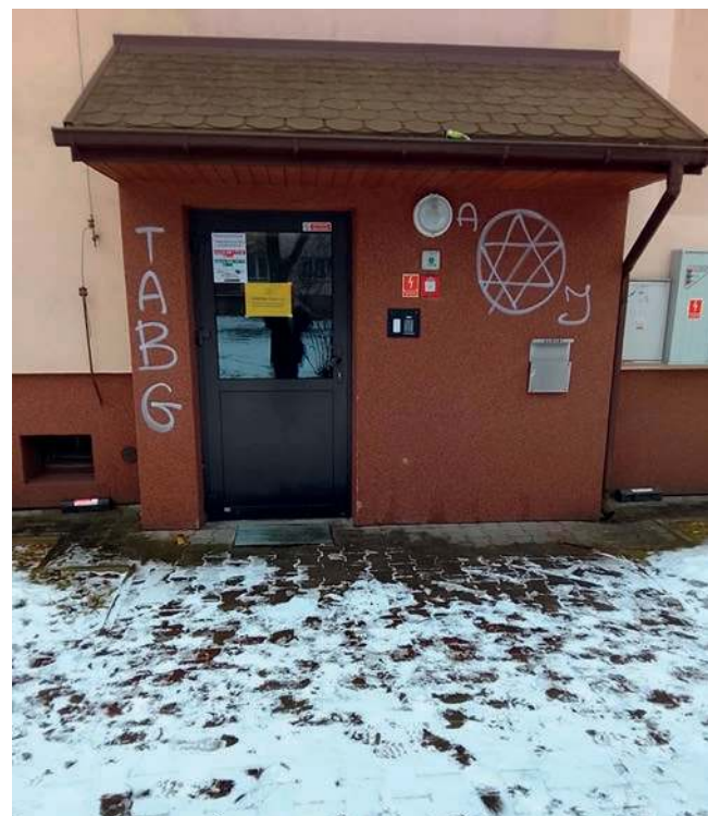
Zniszczenie wejścia do klatki bloku przy Głowackiego
