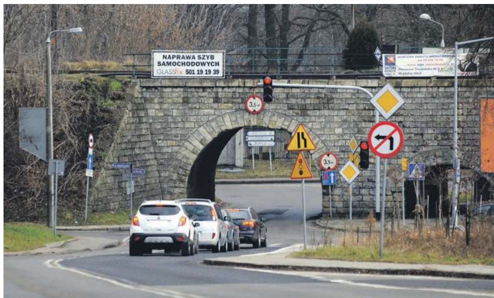
Wiadukt na Siennej w Chrzanowie nie powinien zostać rozebrany ze względu na zabytkowy charakter
