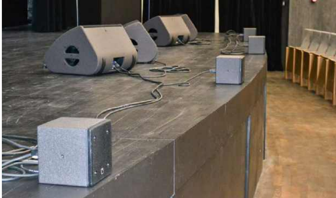
4 zestawy 5XT wykorzystywane są jako nierzucające się w oczy, ustawione na scenie frontfille.
