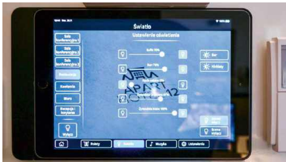
Centralne sterowanie wieloma funkcjami, w tym nagłośnieniem we wszystkich strefach, oświetleniem, roletami itd., jest możliwe z poziomu ekranu dotykowego (iPada) w recepcji hotelu.
