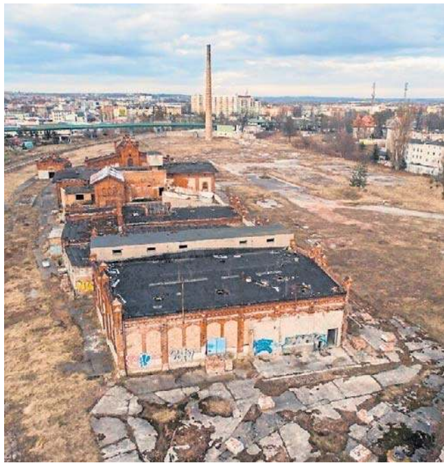
Teren po zakładach mięsnych w centrum Grudziądza od wielu lat straszy ruinami
