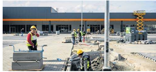
W miejscu dawnego centrum handlowego Glinki finiszuje budowa Comfy Parku o powierzchni 16 000 m kw
