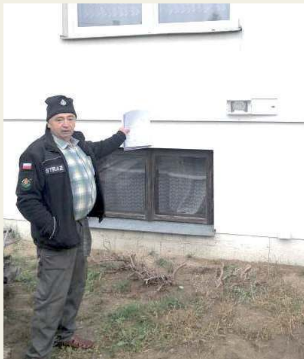
W związku z problemami dotyczącymi DW 835 kilkakrotnie odwiedzaliśmy pana Henryka Bazana z Rogali, którego dom uległ zniszczeniu podczas remontu drogi. Byliśmy tam, kiedy 23 września drogowcy pojawili się w Rogalach, by wykonać wjazd na posesję pana Henryka. Właściciel w obawie o pękające ściany swojego domu nie chciał pozwolić na wykonywanie prac z użyciem ciężkiego sprzętu. Drogowcy wezwali policję. Po interwencji policji rozpoczęto budowę wjazdu przy skrupulatnym pilnowaniu granicy działki i pasa drogowego
