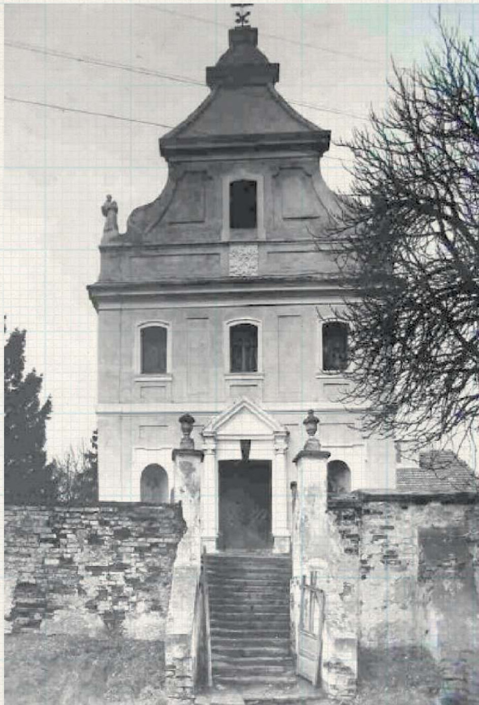
Skrzydło klasztoru przerobione w l. 1794-1796 na kościół
