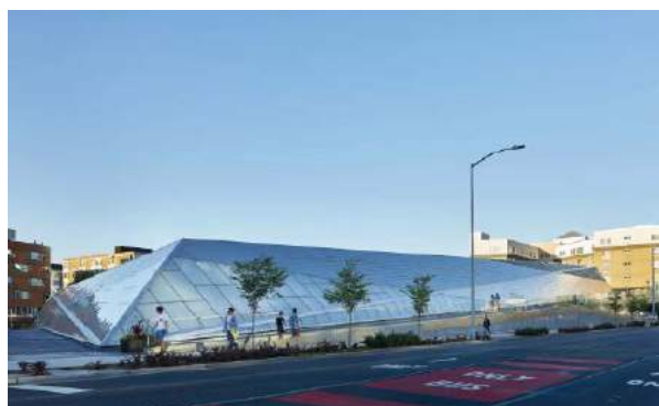
1. Podstacja elektryczna w Seattle
