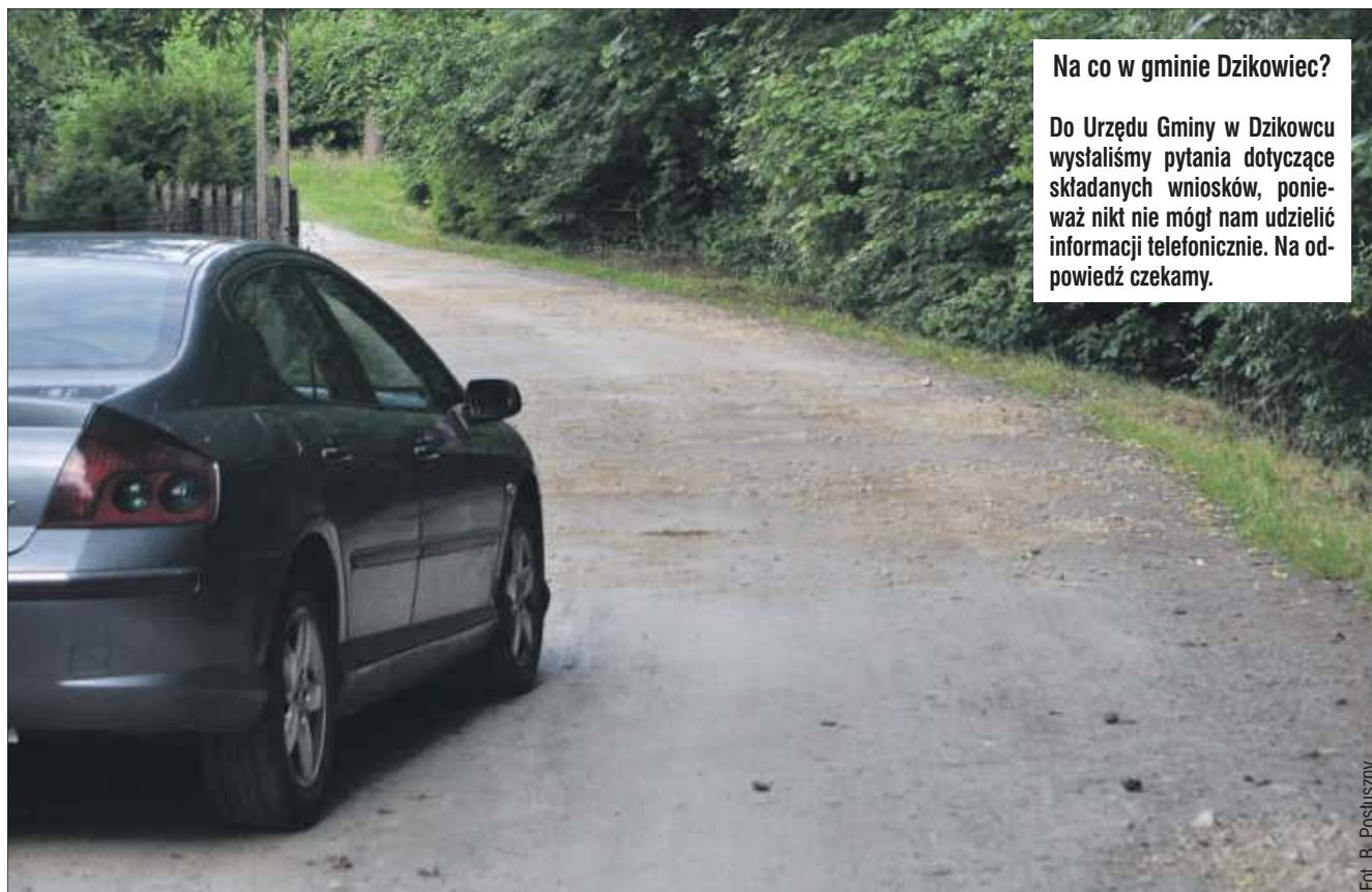
Wiele wskazuje na to, że remontu już niebawem doczeka się droga w Jamnicy (Trzęsówka), o którą od wielu lat zabiegają mieszkający przy niej osoby.
